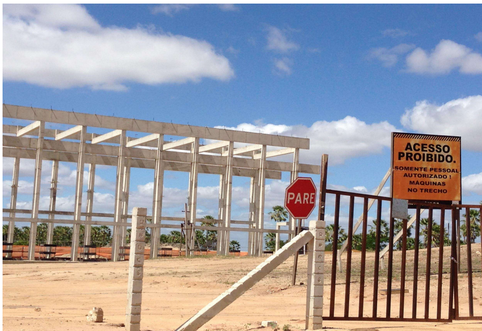
Figura 5: Obras destinadas à construção da estação de bombeamento do Perímetro Irrigado de Santa Cruz do Apodi.
